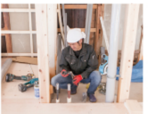
◆施工現場では様々な状況に合わせて臨機応変に配管の調整を行います
